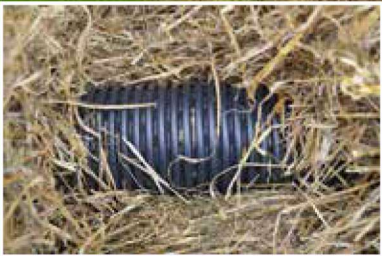
Перфорированная дренажная труба с соломой для предотвращения попадания песка
