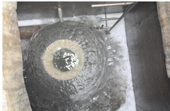
Из усреднителя сточные воды насосом через распределительную камеру подаются на биологическую очистку - в аэротенки. В аэротенках происходит окисление органических загрязняющих примесей сточных вод микроорганизмами активного ила и удаление биогенных элементов.
