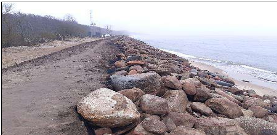
Рис. 3.15. Восстановленный аварийный участок авандюны в восточной части г. Зеленоградска и корня Куршской косы
