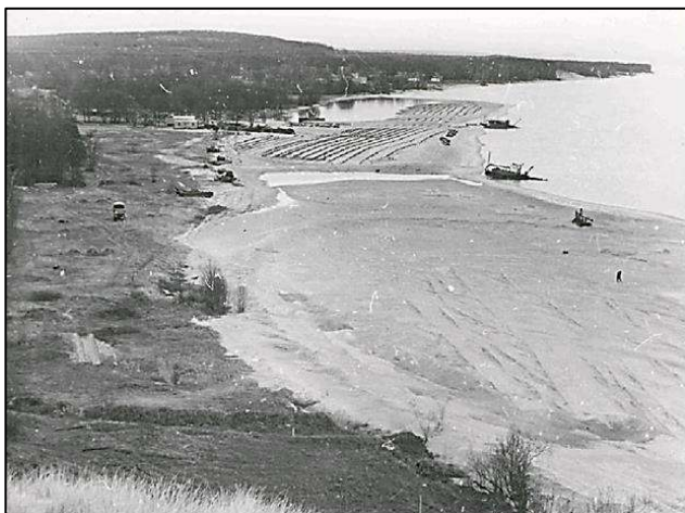
Вид на пос. Морское со стороны залива в процессе восстановления берегов
