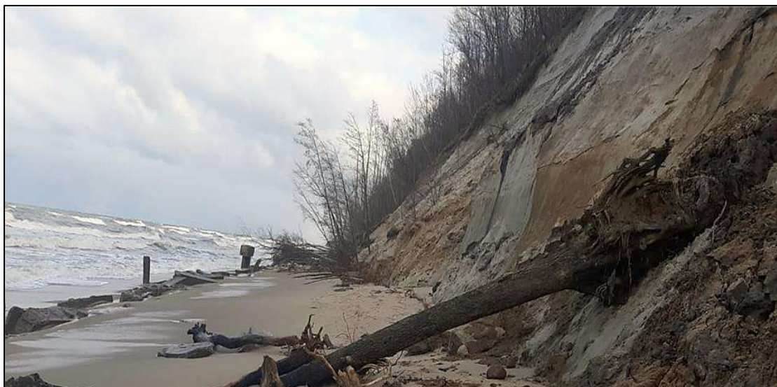
Рис. 3.10. Абразионно-оползневой берег на аварийном участке в районе санатория «Янтарный берег» в г. Светлогорске после серии штормов января 2022 года
