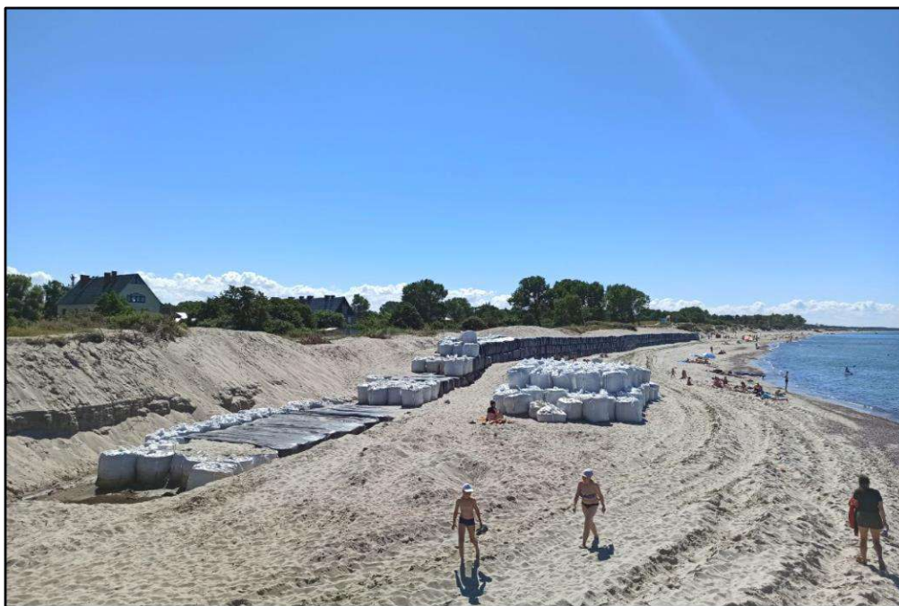
Рис. 3.14. Восстановленный и укрепленный участок берега Балтийского моря в районе пос. Коса на Вислинской косе
