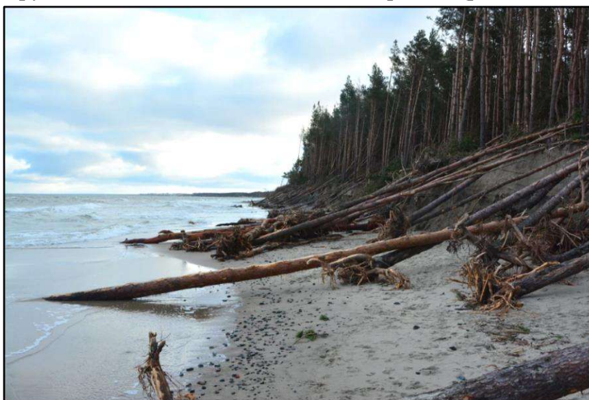
Рис. 3.13. Аварийный участок берега в районе пос. Куликово
