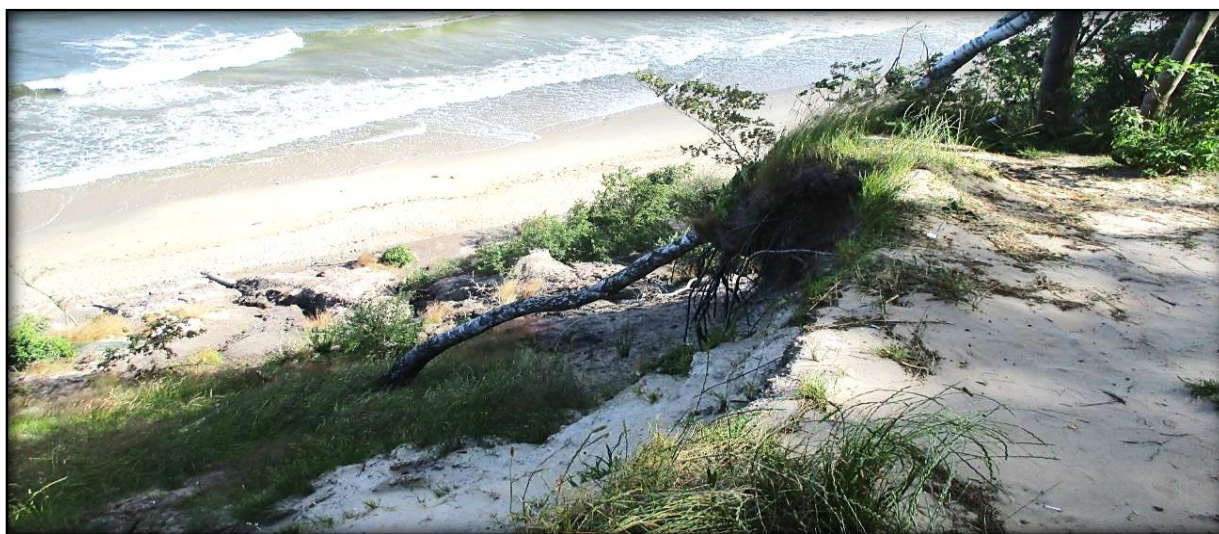
Рис. 3.11. Аварийный участок морского берега в г. Светлогорске
