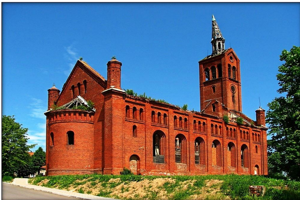
Рис. 13.13. Кирха Даркемена, г. Озерск
