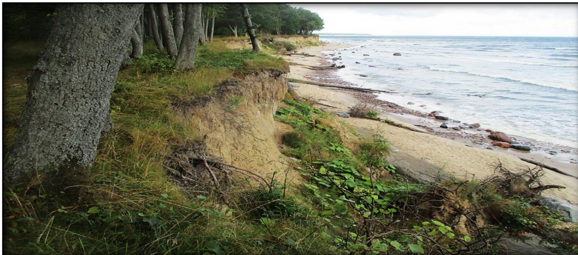
Рис. 3.12. Аварийный участок морского берега в районе пос. Куликово
