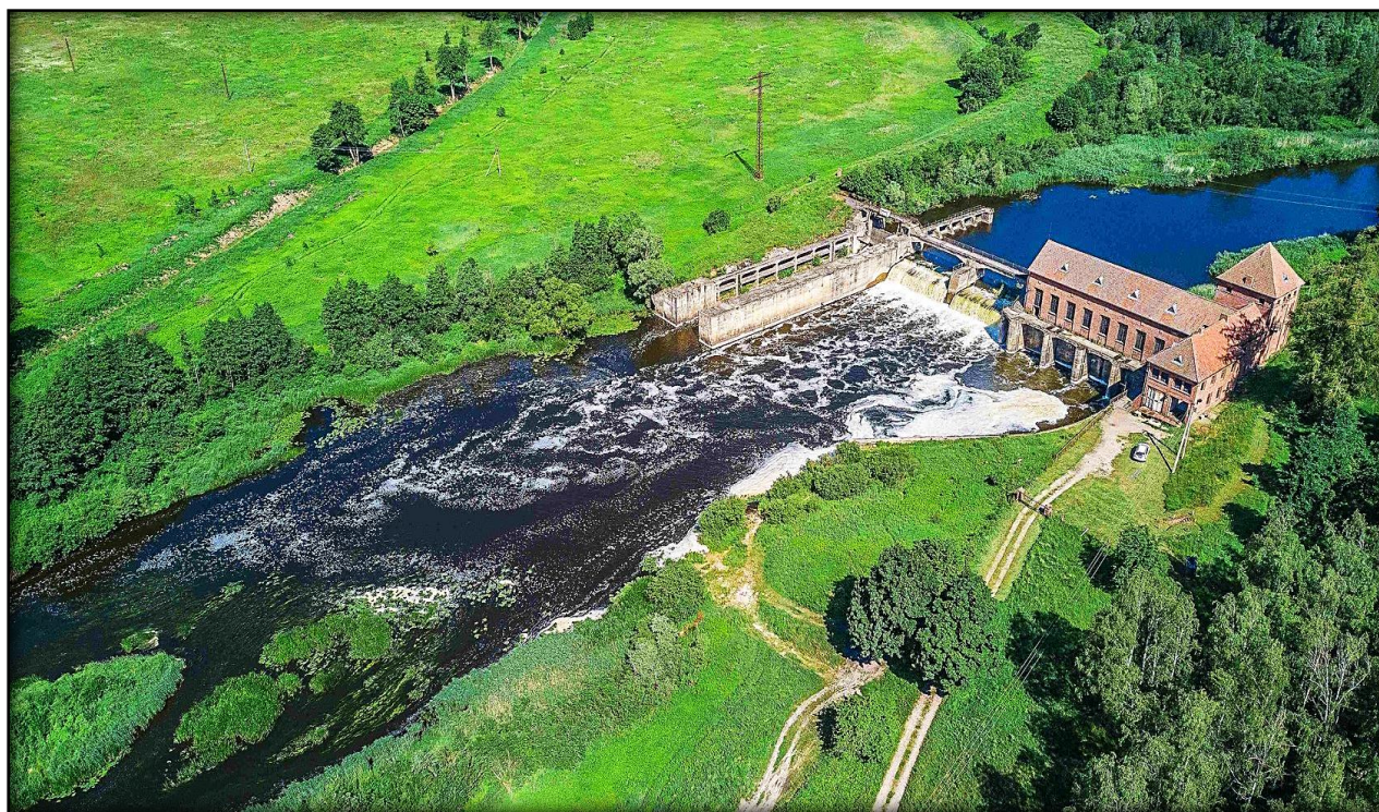
Рис. 3.9. Заброшенная ГЭС-4 на реке Лава
