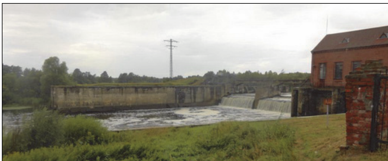
Рис. 7.1. Гидроэлектростанция на реке Лава в пос. Курортном МО «Правдинский район» (август 2013 г.)
