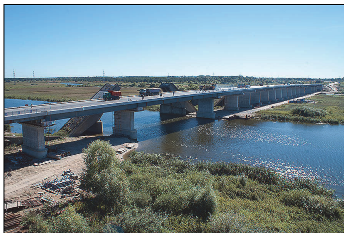
Рис.2.9. Работы по реконструкции Берлинского моста
