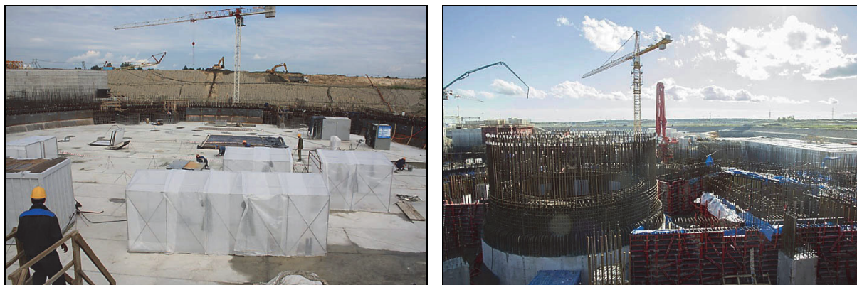
Рис. 1.8. Строительство Балтийской АЭС в 2013 году
