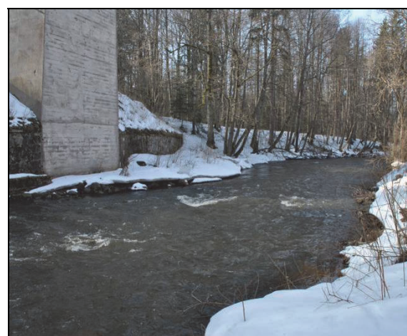
Рис. 3.22. Участок русла р. Красной в районе пос. Токаревки
