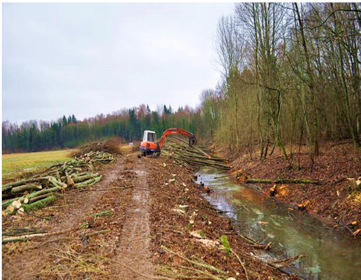
Работы по уходу за мелиоративной сетью в Калининградской области
