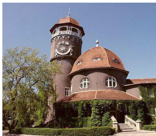
Водонапорная башня г. Светлогорска
