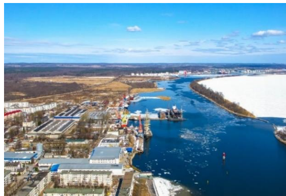
Правдинская ГЭС-3 на реке Лава
