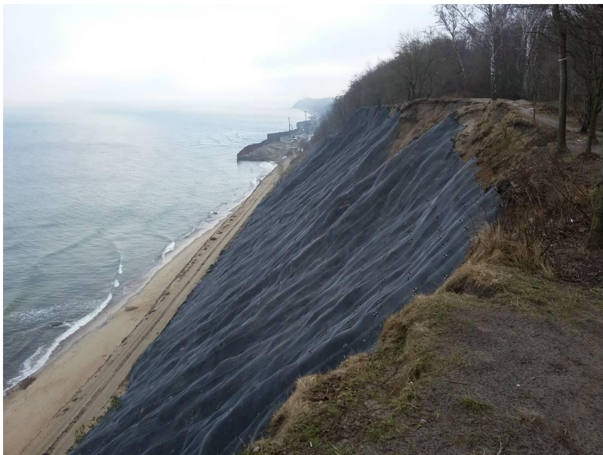
Участок закрепленного оползнеопасного берегового склона в восточной части города Светлогорска
