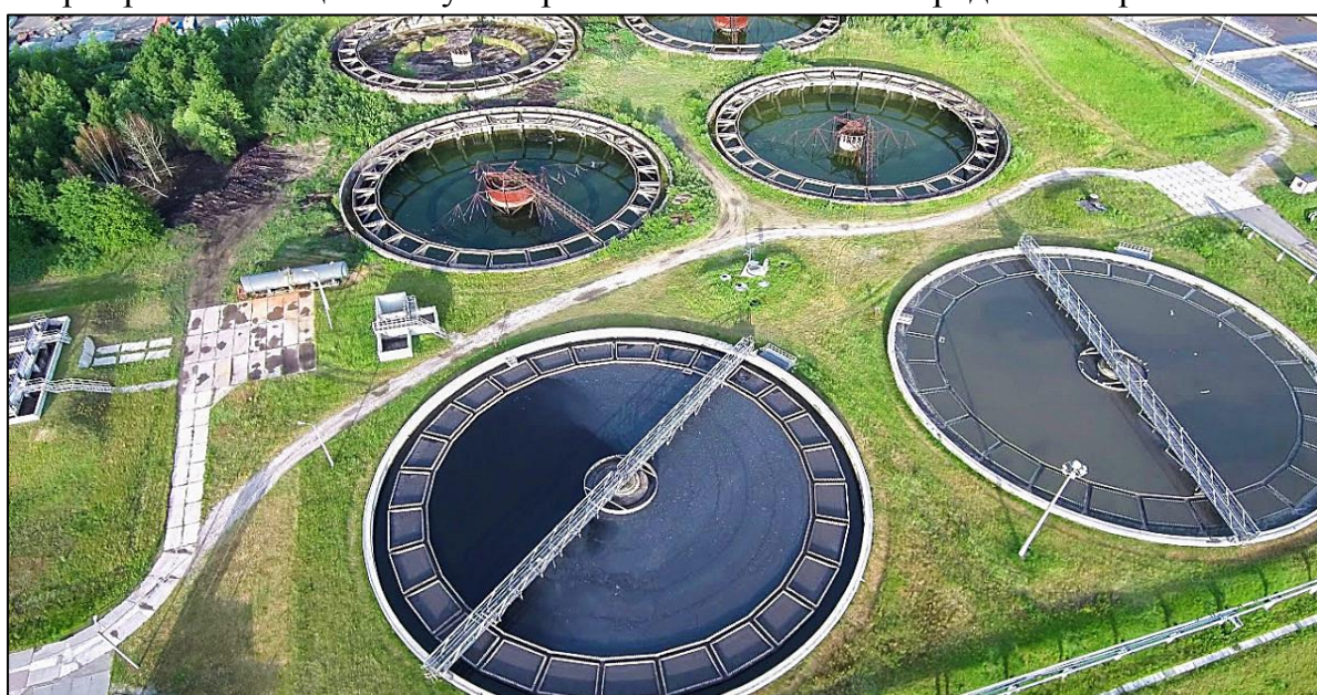
Рис. 3.28. Канализационные очистные сооружения г. Калининграда
