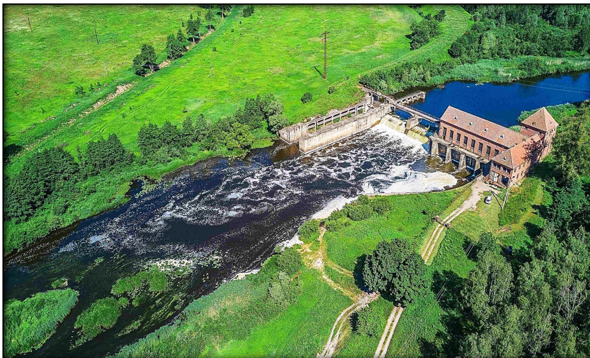
Рис. 3.8. Заброшенная ГЭС-4 на реке Лава
