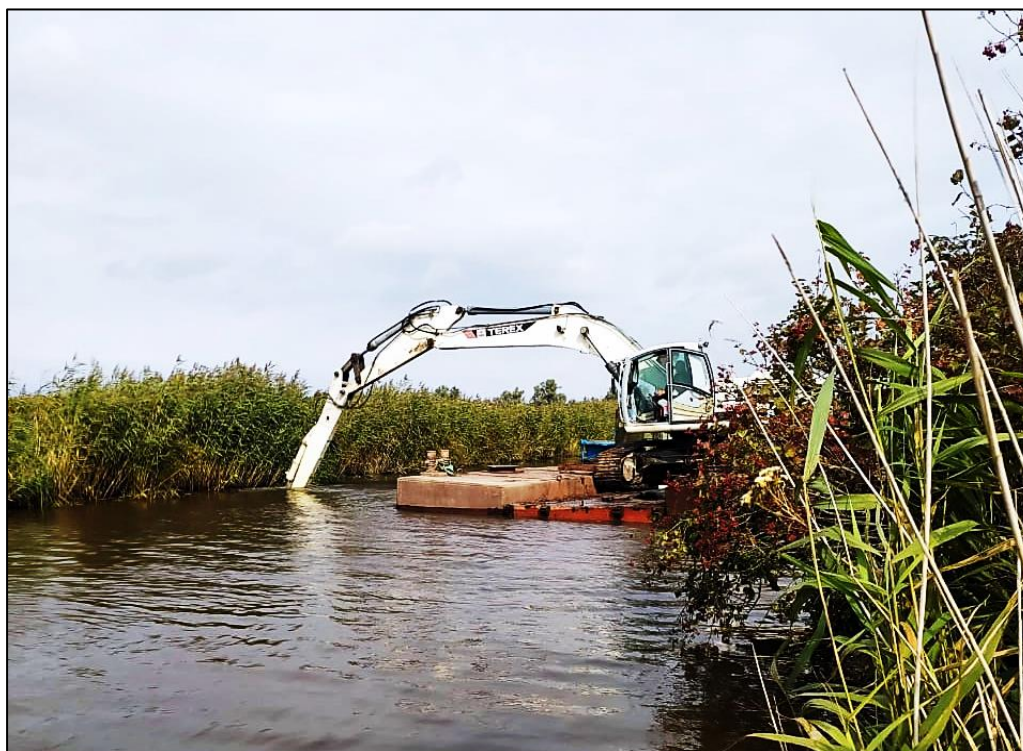
Рис. 3.24. Выполнение работ по расчистке русел рек
